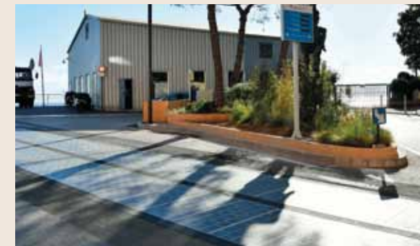
Des dalles solaires ont été installées sur une portion de route à Fontvieille pour une période test.
